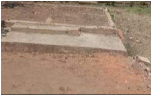
Toilet dalam tahap pembongkaran
